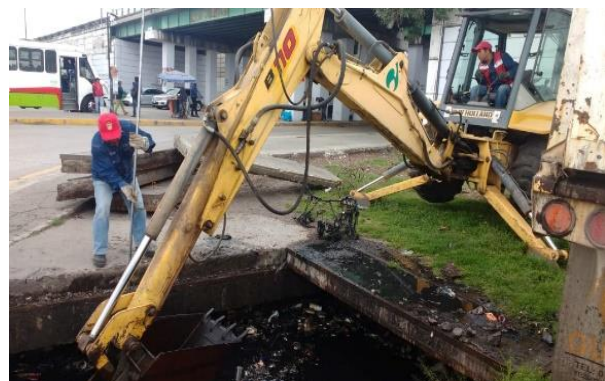
Retiro de basura de alcantarillas y limpieza de las cajas. Canal Zapata, San Mateo Atenco
