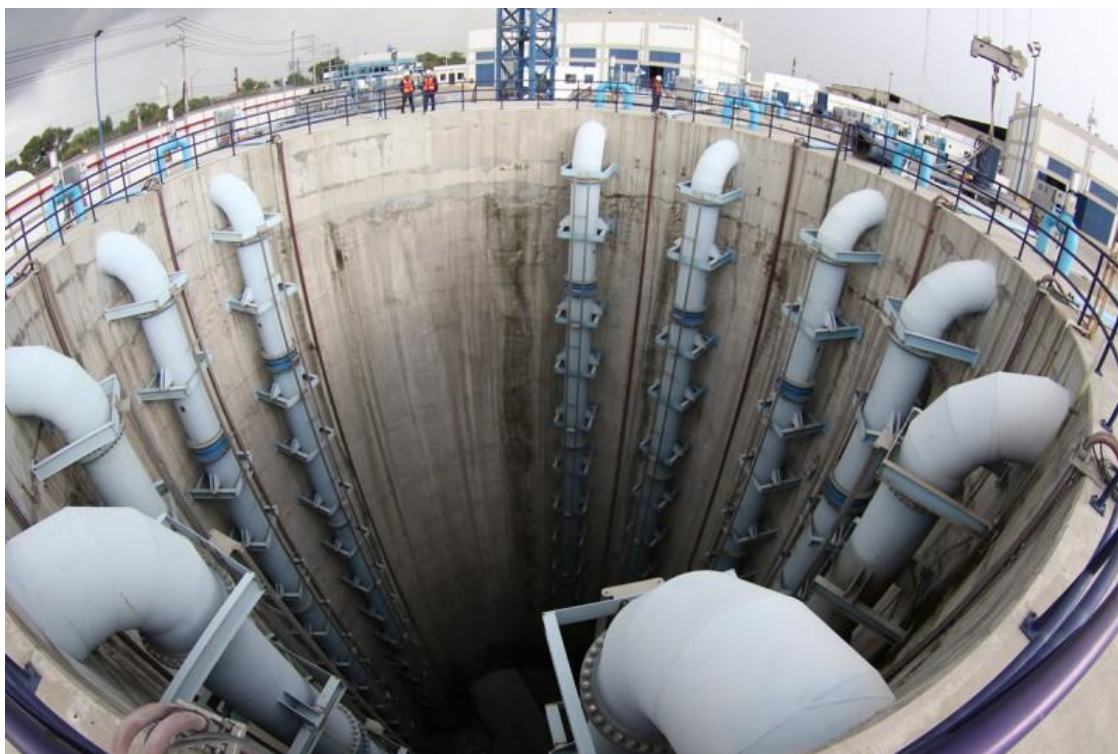
Túnel Emisor Oriente
