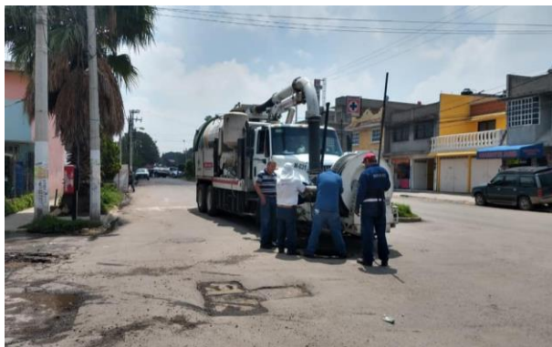
Desazolve de redes de drenaje. La Guadalupe, Ecatepec.
